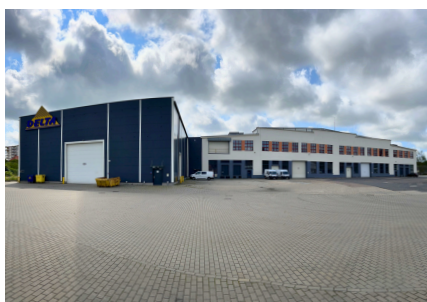
plac manewrowy i składowy
